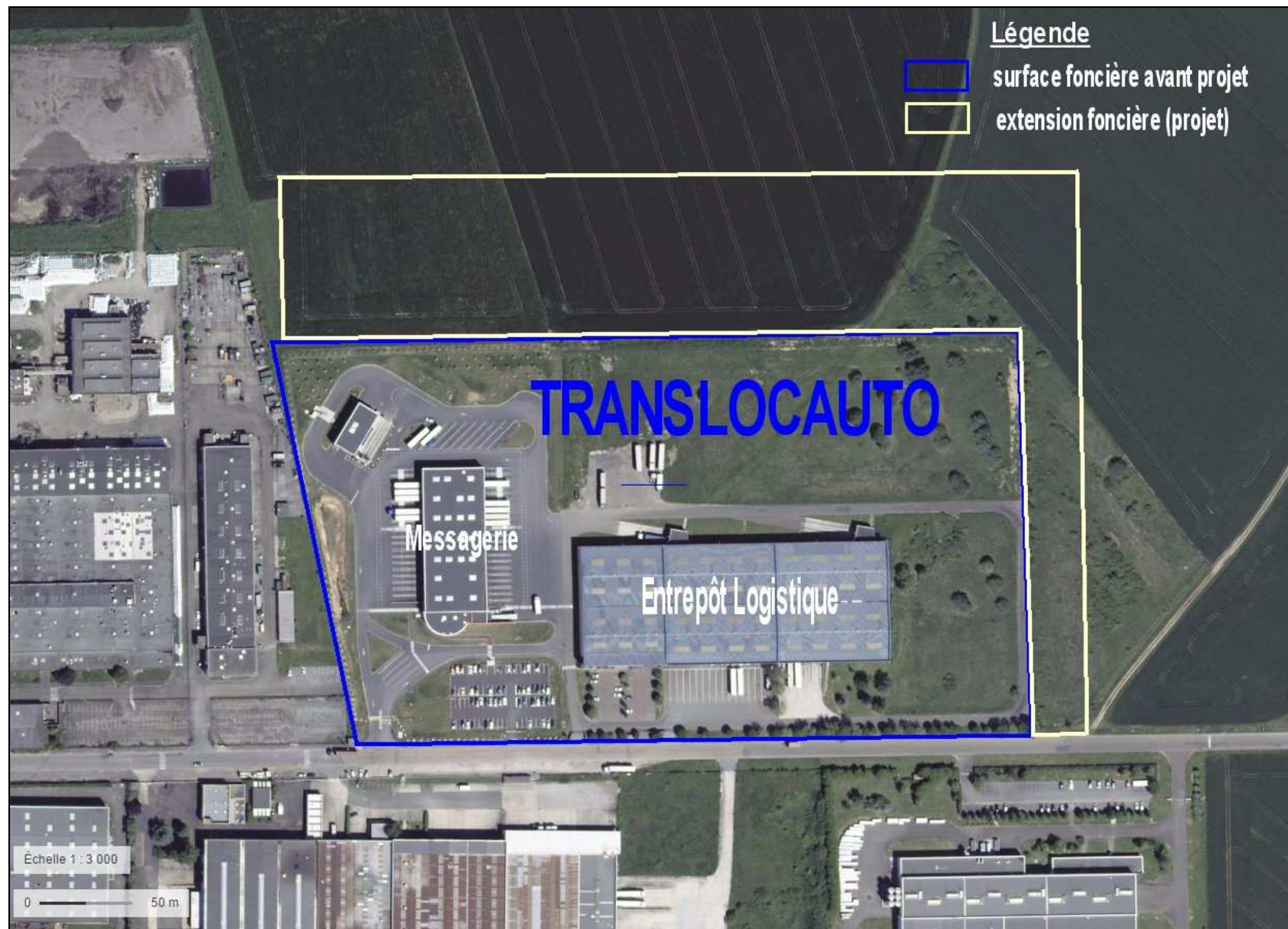
Figure 2 : vue aérienne du site TRANSLOCAUTO (avec projet extensions)
